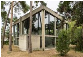
Außenansicht; Glasbau im Föhrenwald.
